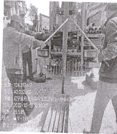
1#土壤柱状样检测点位
